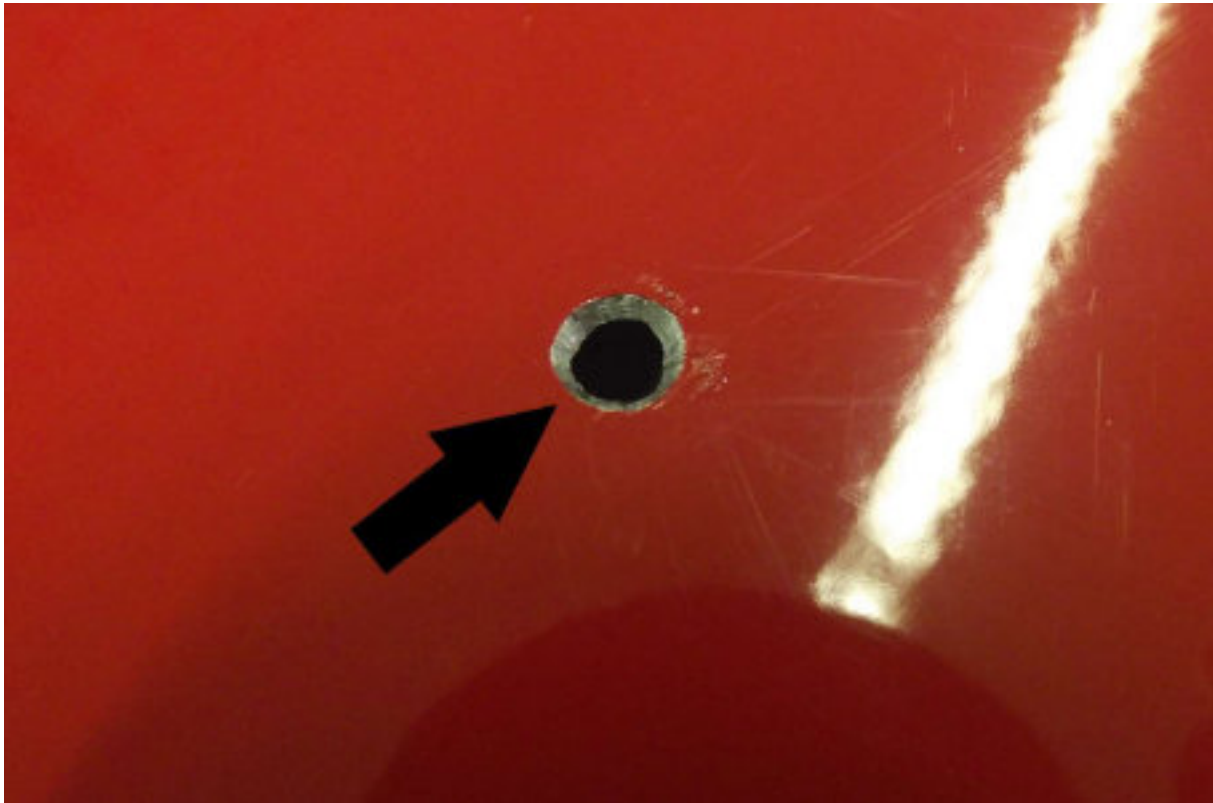
Abbildung 7: Bohrung in Rückseite des FIREPANELsentgratet / gesenkt
