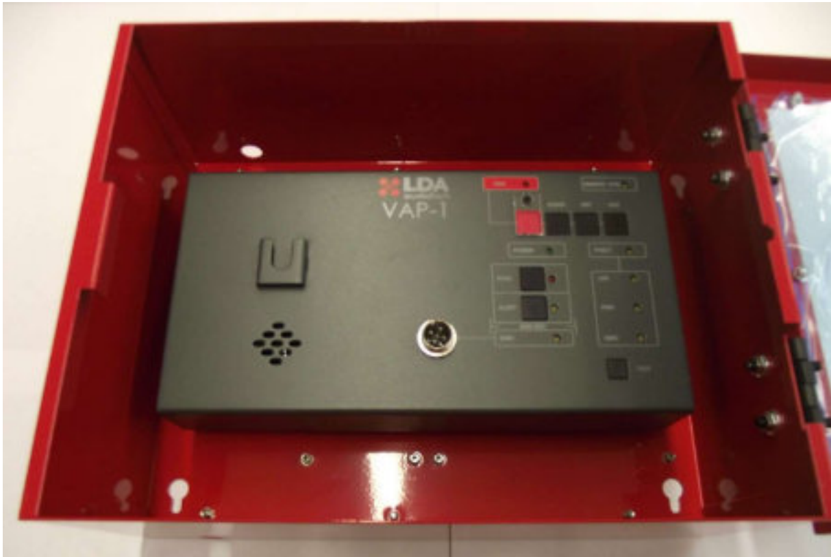
Abbildung 12: VAP-1 in FIREPANEL eingesetzt
